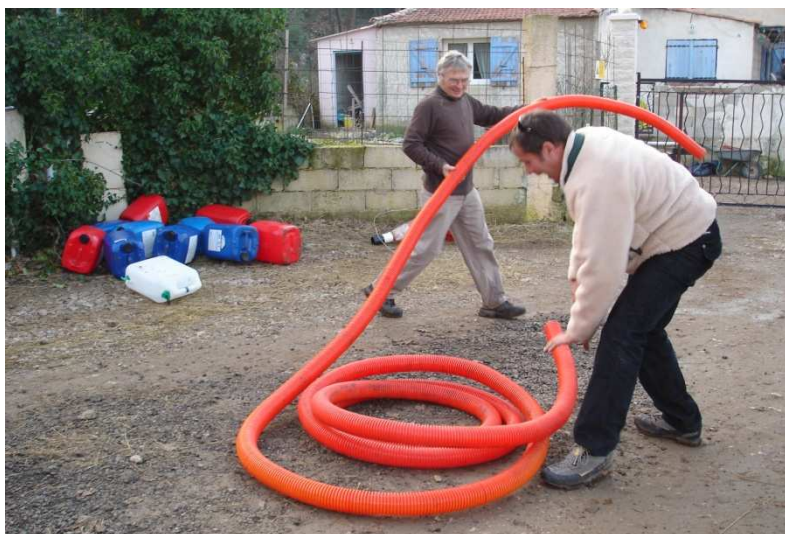
Photo 18 : Rangement du tuyau d'injection installé dans l'embut
