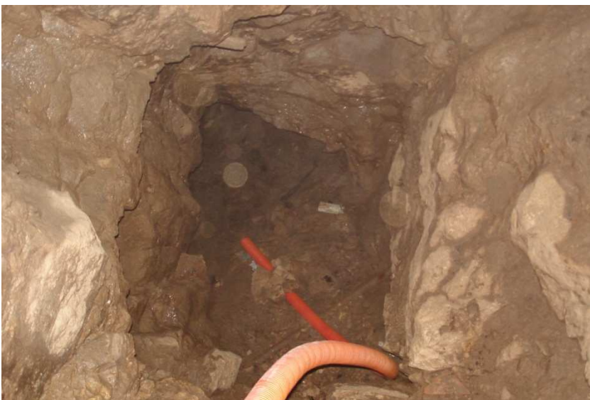
Photo 11 : Le puits de l'embut sud-ouest vu du haut – Installation du tuyau (75 mm diamètre) d'injection au fond de l'embut
