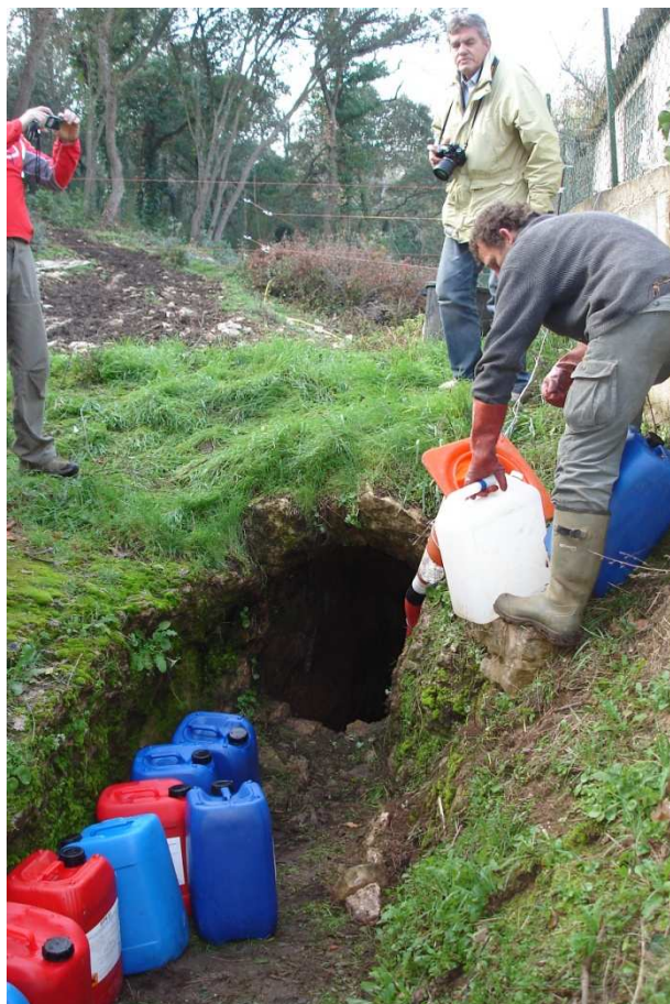
Photo 12 : L'entrée de l'embut sud-ouest – Tuyau (75 mm diamètre) d'injection installé en sortie.
