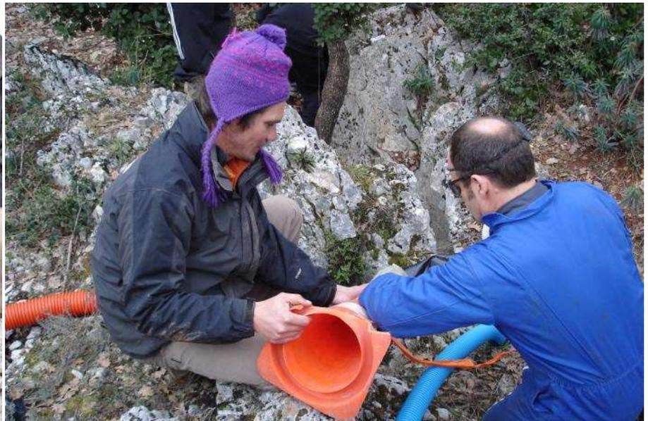
**Photos 7 : Installation du tuyau d'injection à partir de la surface**
