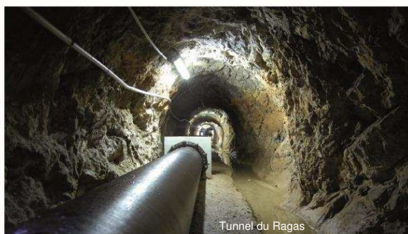
Tunnel du Ragas
